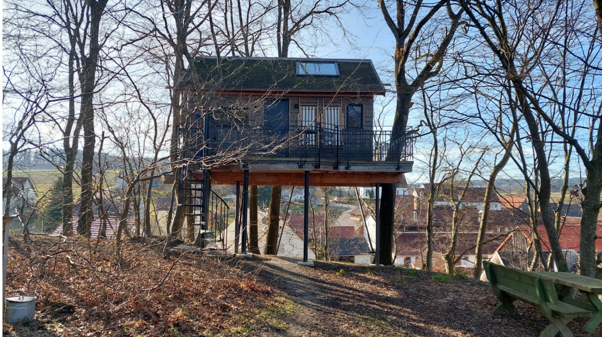
Abb. 4: Bestehendes Baumhaus von 2018.
